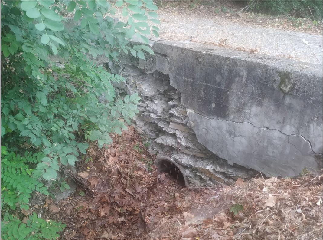
**Figura 2 – Foto tombino ponticello condotta in CLS DN500 mm**
