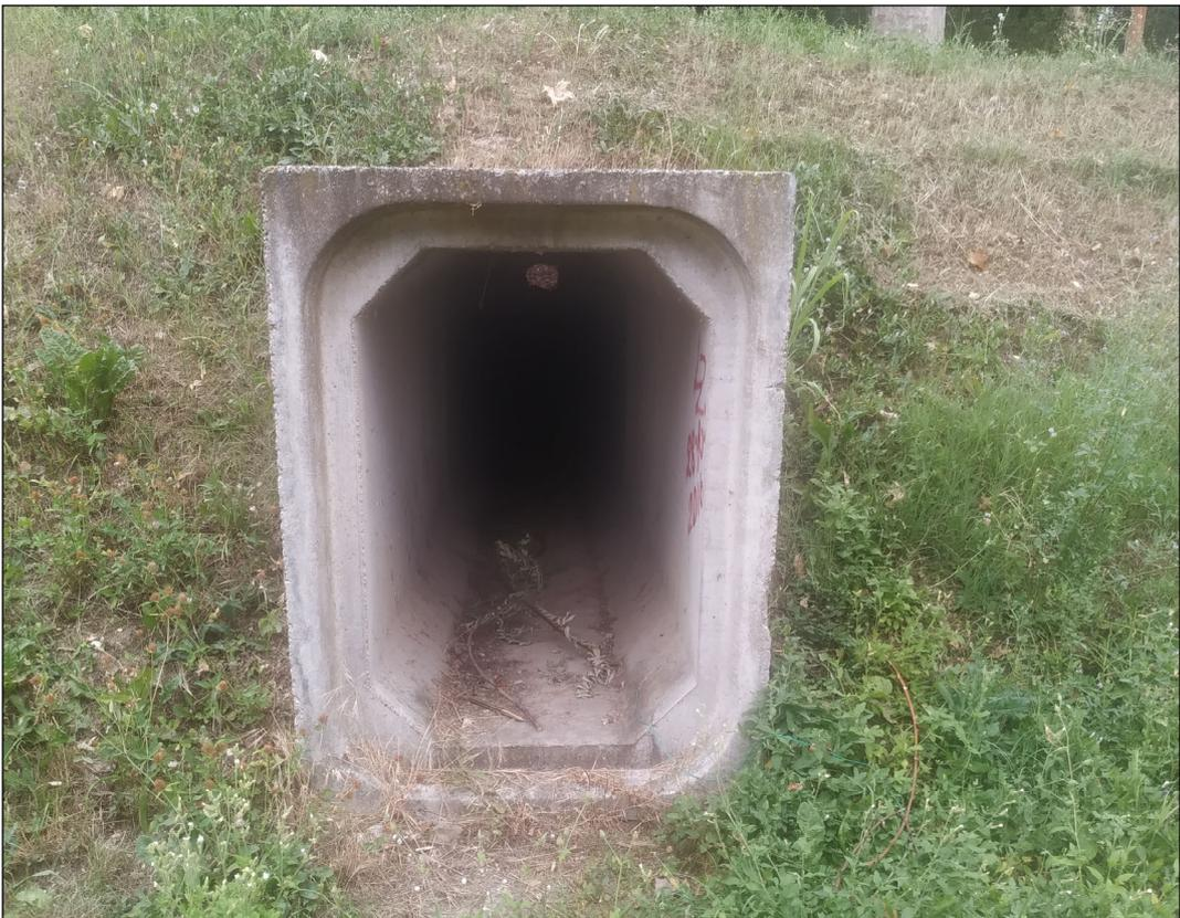
**Figura 3 – Foto condotta scatolare in CLS 1500x1000 mm in attraversamento stradale**
