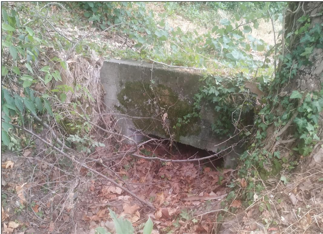
**Figura 1 – Foto tombino ponticello condotta scatolare in CLS 1000x500 mm**
