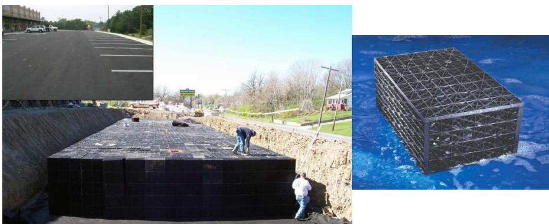
*Esempio vaso sotterraneo con celle in materiale plastico*
